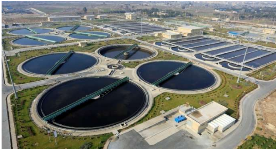
شکل (۸): حوضه‌های مستطیلی و دایره‌ای به کار رفته در واحد هوادهی و ته‌نشینی ثانویه
