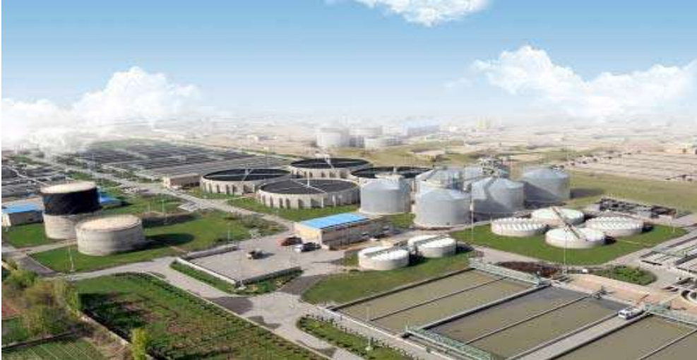
شکل (۹): نمایی از تصفیه خانه فاضلاب جنوب تهران شامل هاضم‌های لجن فعال
